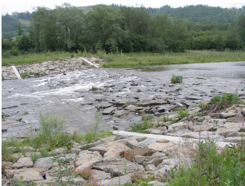
Rys. 6. Bystrze na potoku Porębianka; należy zwrócić uwagę na koncentrację przepływu na płycie spadowej bystrza, zapewniające przechodzenie ryb nawet przy niskich stanach wody (fot. A. Radecki-Pawlik)
