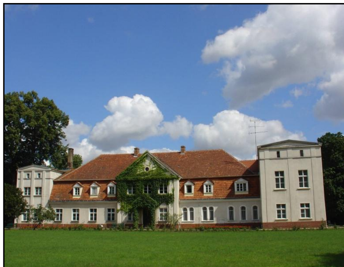
Rys. 1. Frontowa, południowa elewacja dworu (2005 r.) Fig. 1. Front, south manor house elevation (2005)
