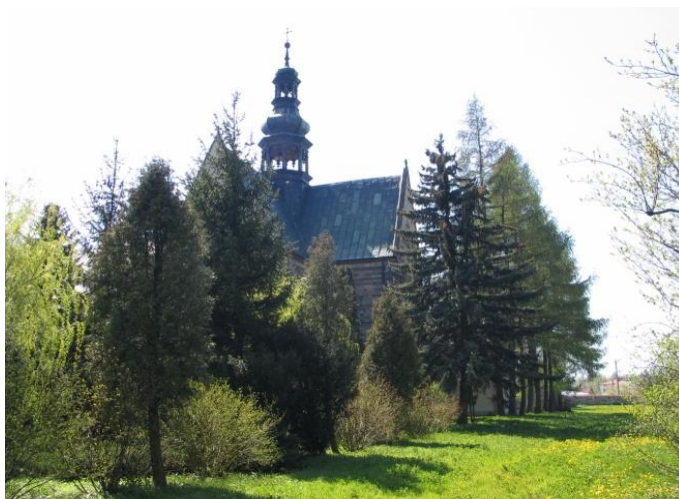
Rys. 1. Wąchock. Kościół widziany z ogrodów klasztornych (fot. M. Milecka)
