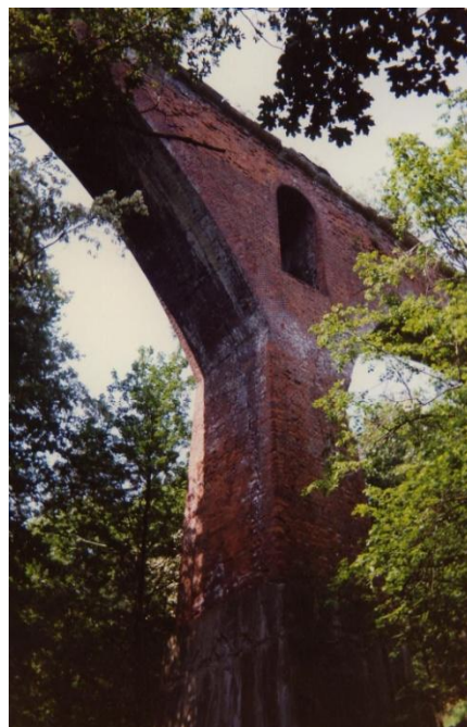
Rys. 5. Ceglany słup wiaduktu kolejki wąskotorowej w Srebrnej Górze (fot. R. Mianowski)
