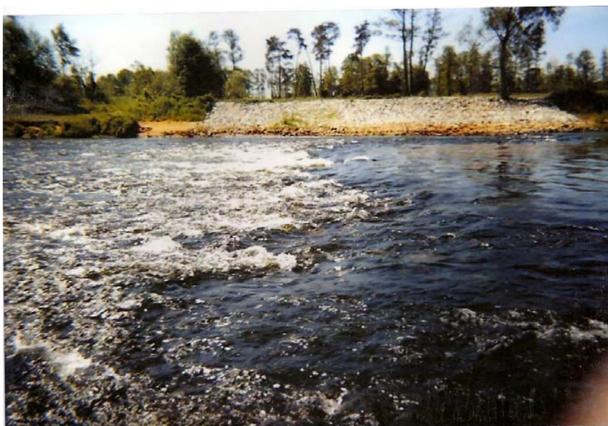
Fot. 1. Warta w km 480+900. Widok progów nr 3 z lewego brzegu rzeki przy Q = 23,5 \text{ m}^3/\text{s} (12.06.2006)
