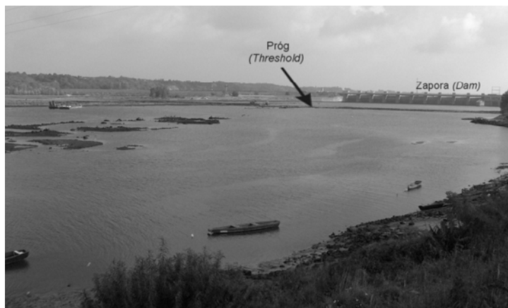
Fot. 1. „Wyczyszczone” z osadów dno koryta Wisły zapory wodnej i progu stabilizującego. Widoczne głązy i ły (sierpień 2006) Phot. 1. From materials “cleaned” channel bed of Vistula below dam and threshold. Visible stones and clays on bottom (August 2006)
