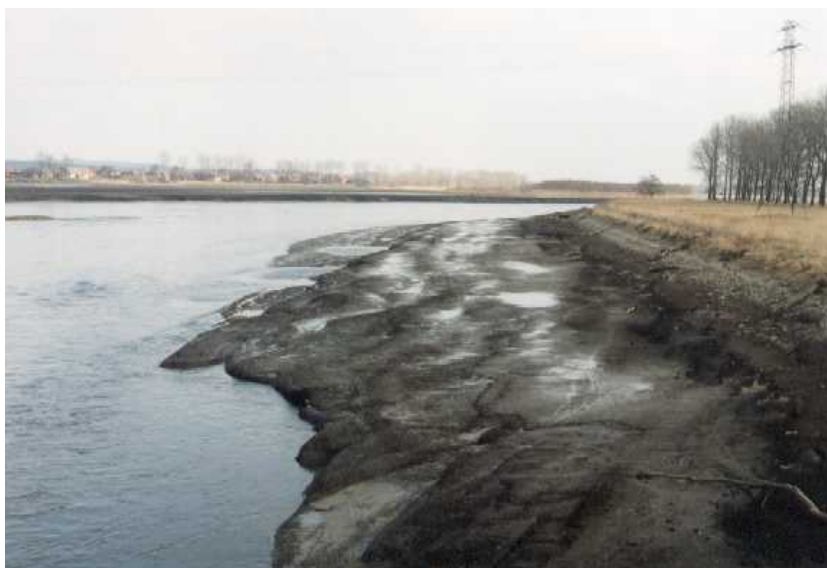
Rys. 6. Półwysp osadów na górnym stanowisku stopnia w Brzegu Dolnym Fig. 6. Island of sediments upstream the barrage Brzeg Dolny
