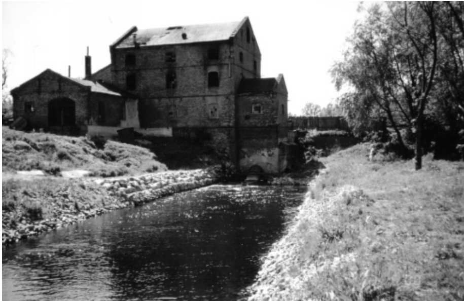
Fot. 1. Mała elektrownia wodna w Nowym Młynie Phot. 1. A small hydro-electric power station in Nowy Młyn
