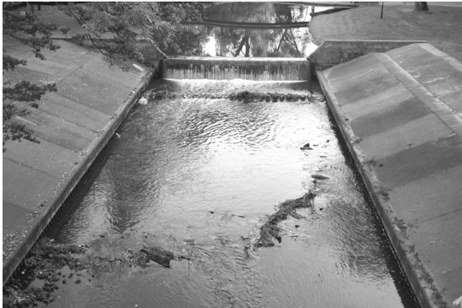
Fot. 2. Próg korekcyjny na Zgłowiączce we Włocławku Phot. 2. Correction step on the River Zgłowiączka in Włocławek
