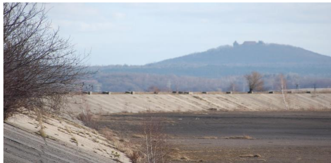
Rys. 6. Fragment wyłączony z eksploatacji składowiska odpadów flotacyjnych „Wartowice”. W oddali widoczny zamek Grodziec
