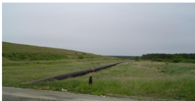
Rys. 3. Odształcenia powierzchni ziemi – eksploatowane składowisko odpadów flotacyjnych „Żelazny Most”
