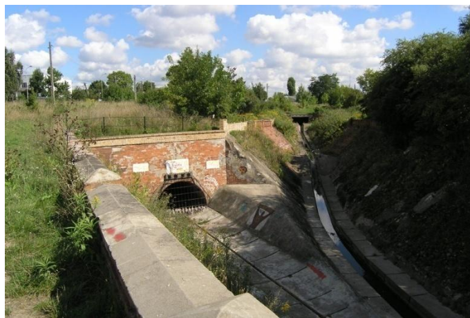
Rys. 2. Jasień w betonowym korycie przebiega długim odcinkiem w części zachodniej, aż do ujęcia do Neru. W okolicy – rozproszona zabudowa mieszkaniowa o słabej tkance (fot. B. Sierecka-Nowakowska) Fig. 2. A long part of the river Jasień flows, in its concrete bed, in the west side, up to its intake to the river Ner. Around, the scattered residential housing of weak tissue (photo by B. Sierecka-Nowakowska)
