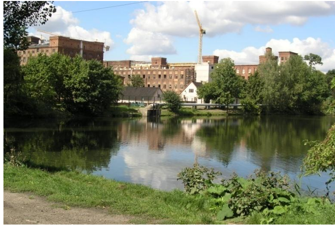
Rys. 3. Ogromna bryła fabryki Scheiblera nad Jasieniem, przekształcona na funkcje mieszkalne (lofty). Wokół rozlewiska – wielohektarowe tereny ogródków działkowych (fot. B. Sierecka-Nowakowska) Fig. 3. The huge block of the Scheibler factory by the river Jasiień converted into residential functions (lofts). Around pools, multihectare fields of allotments (photo by B. Sierecka-Nowakowska)
