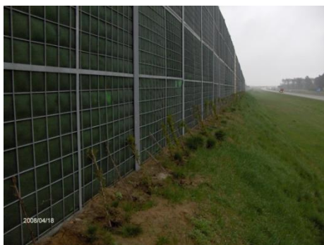
Rys. 11. Nasadzenia pnączy przy ekranie akustycznym typu zielona ściana – droga A2, odcinek Poznań-Września
