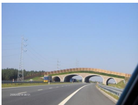
Rys. 3. Przejście dla zwierząt na A2 Konin-Koło – przykładem ciekawego pomysłu wkomponowania w krajobraz. Pokrycie tego wiaduktu wykonano z kamienia, a na górze, na warstwie gleby, założono trawnik
