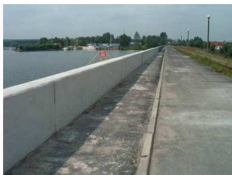
Fot. 4. Falochron od strony odpowietrznej – po remoncie
