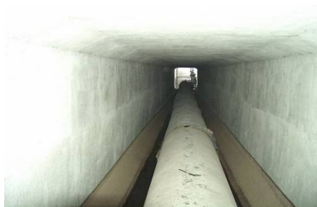
Fot. 6. Widok ogólny sztolni po remoncie
