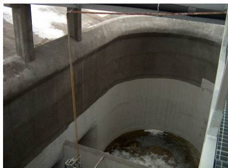
Fot. 2. Wnętrze wieży przelewowej po remoncie
